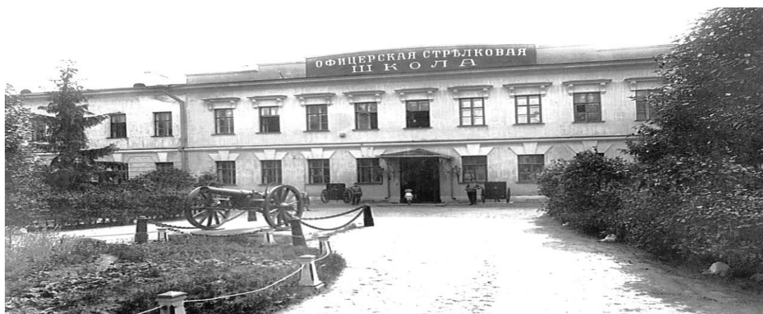
Офицерская стрелковая школа в 1900 – 1915 г.г.
