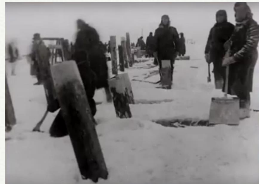
Установка свай для железнодорожных путей
