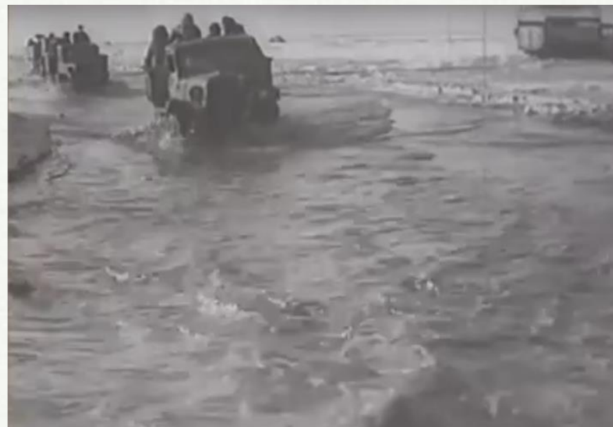
Грузовики, едущие по льду, покрытому трещинами и водой
