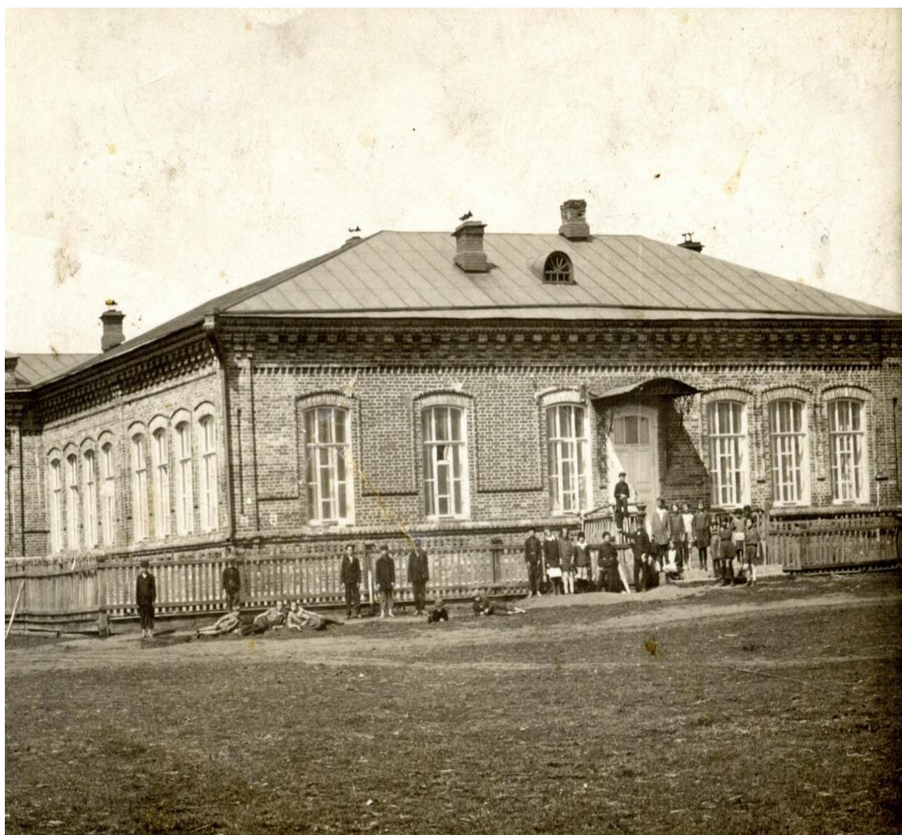
Здание Напольной школы. Алапаевск. Снимок начала XX в.
