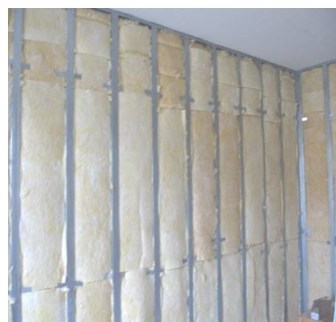
6. Прокладка теплоизоляционного материала
