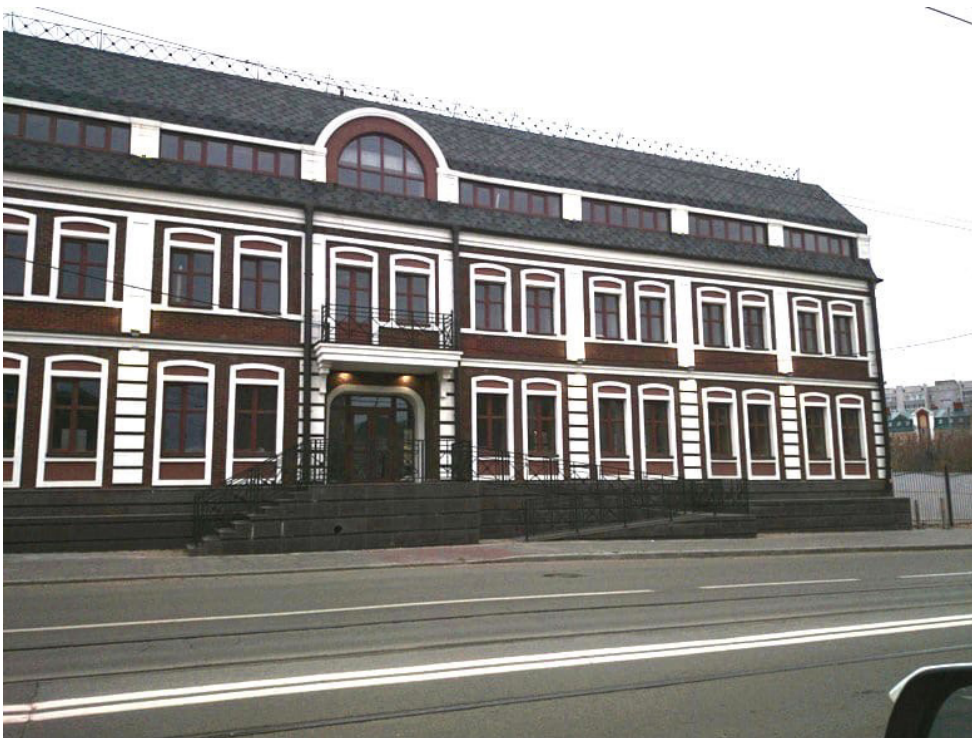
Рис. 4. Вид справа, указатели отсутствуют.
