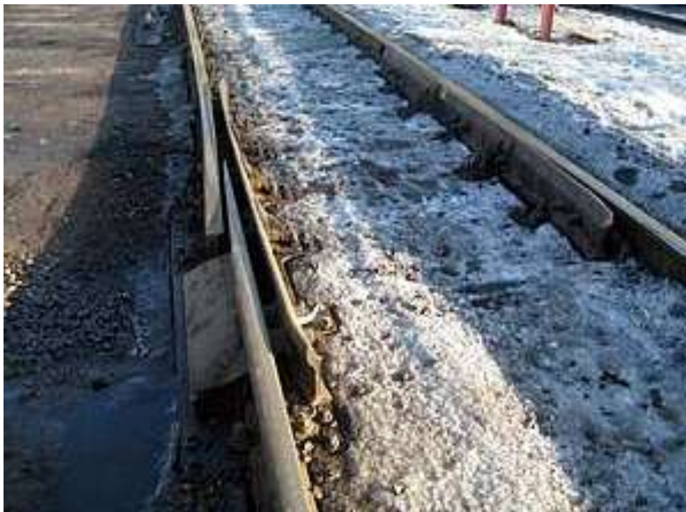
Рис. 3.3. Башмакосбрасыватель
