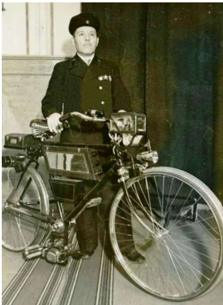
Рис. 4.1. Велодефектоскоп системы Карпова Ф.М.
