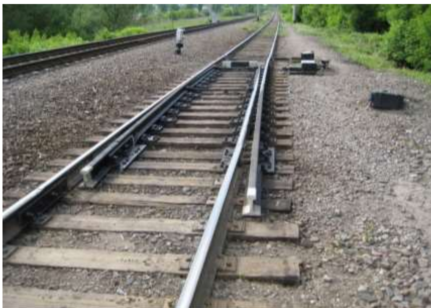
Рис. 2.4. Общий вид сбрасывающей стрелки
