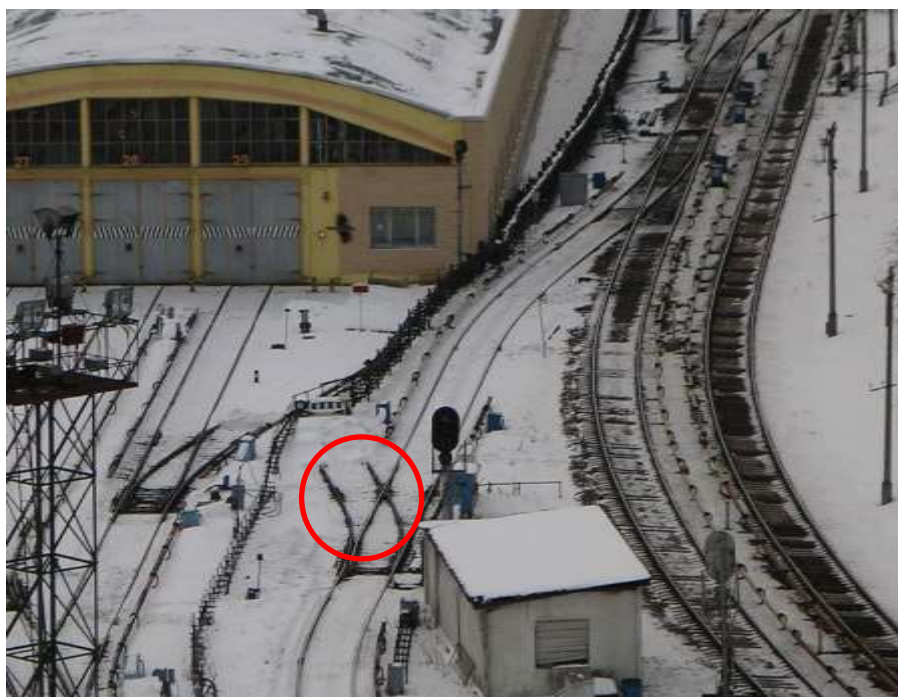
Рис. 2.6. Предохранительный тупик
