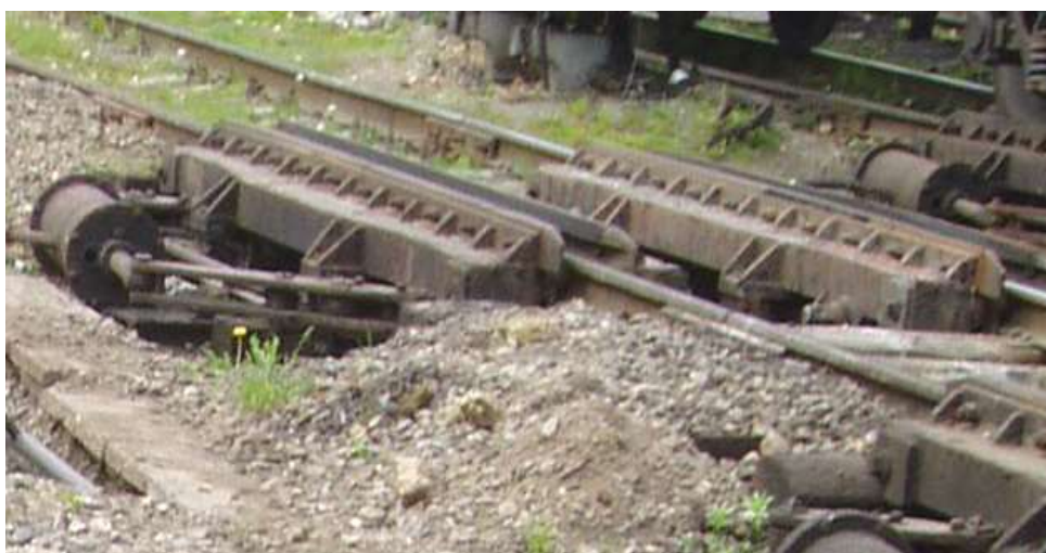
Рис. 3.12. Внешний вид вагонного замедлителя Т-50 (парковый)
