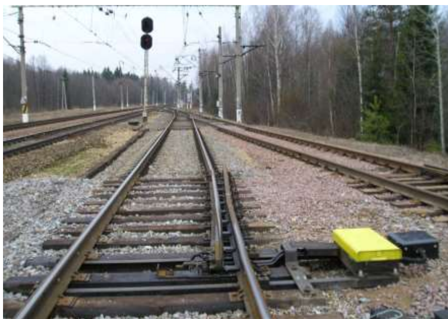
Рис. 2.5. Общий вид сбрасывающего остряка
