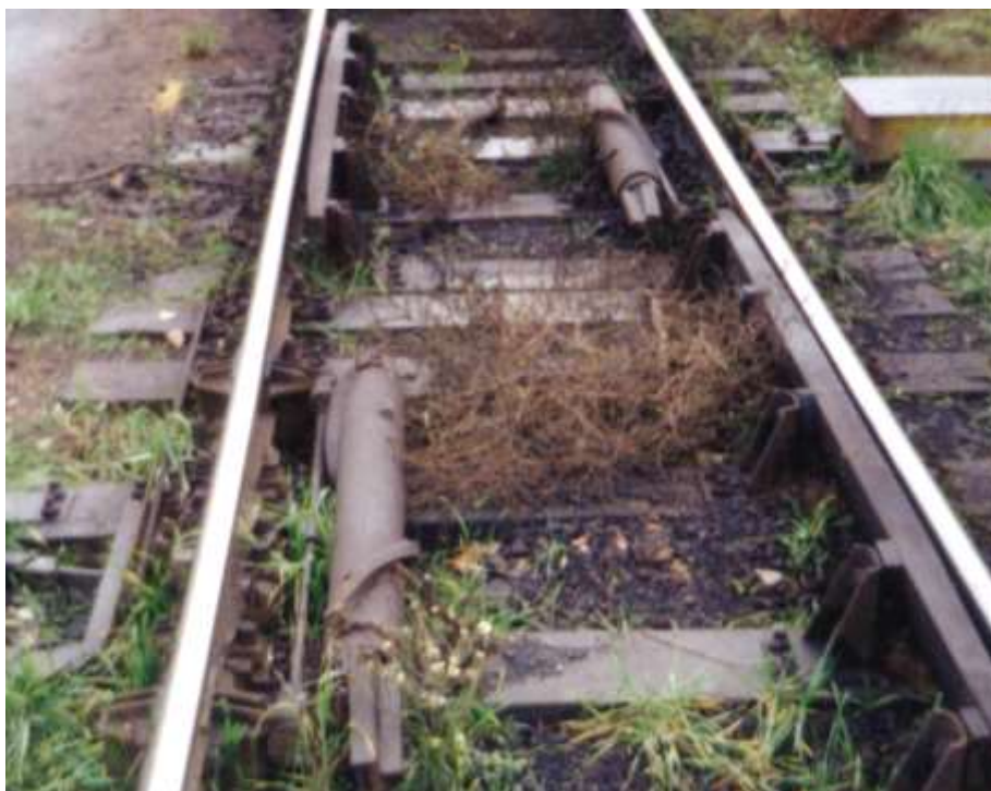
Рис. 3.19. Внешний вид винтового замедлителя (Чехия)
