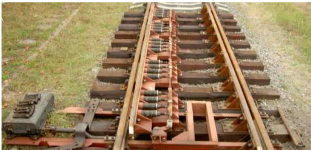
Рис. 2.8. Общий вид балочного заграждающего устройства БЗУ-ДУ
