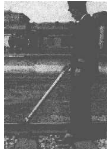
Рис. 4.11. Дефектоскоп УРД-63
